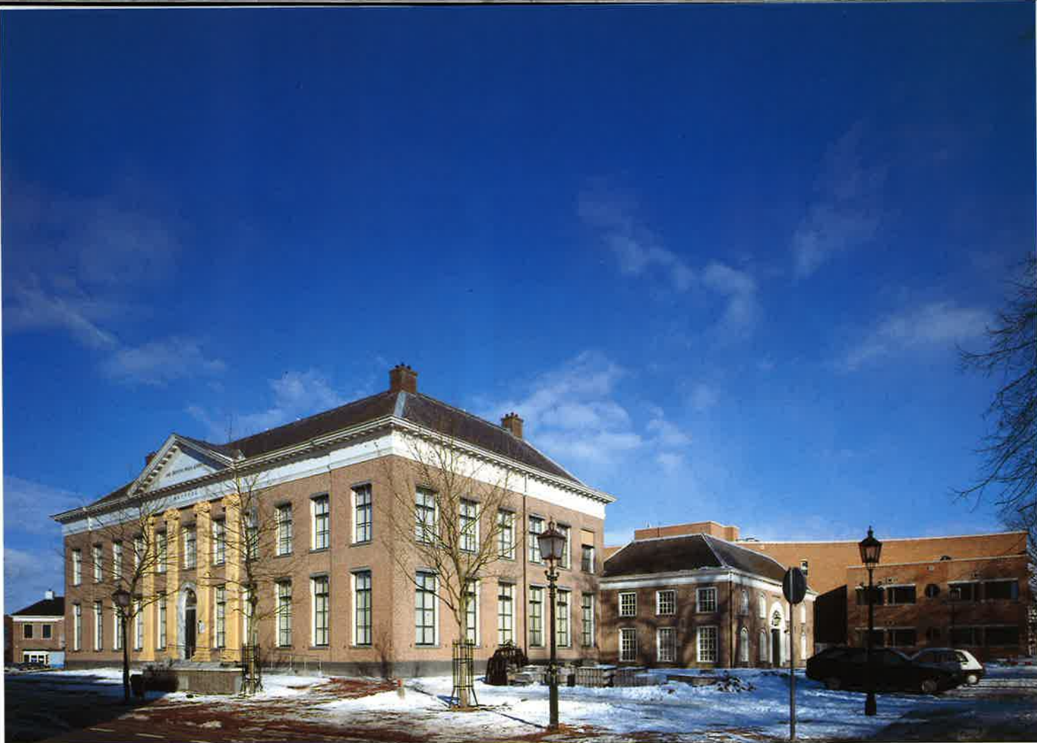
Gerechtsgebouw Assen (Quist Wintermans Architecten)
